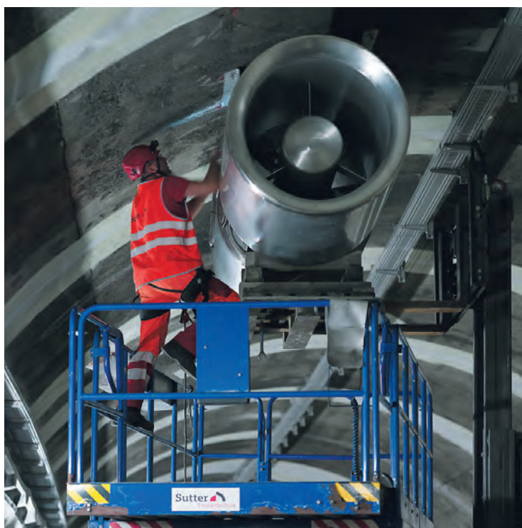
Strahlventilatoren für die neue Tunnellüftung werden montiert.
