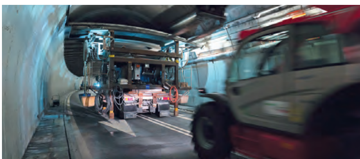
Die Zwischendecke wird abgebrochen und abtransportiert.
