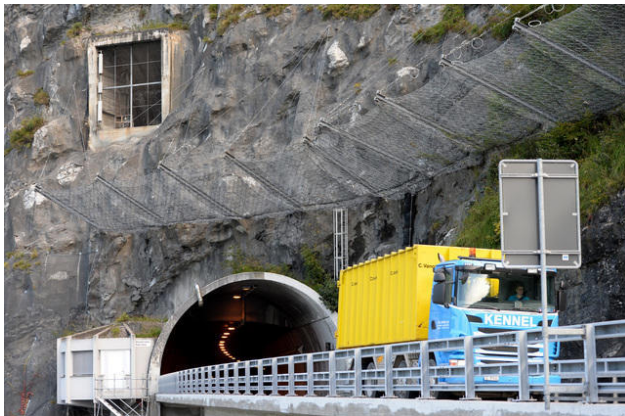
Das Portal des 1,1 Kilometer langen Mositunnels bei Brunnen. (Keystone / Urs Flüeler)
